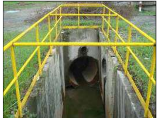
ภาพที่ 12 รางระบายน้ำฝนรอบพื้นที่โครงการ
